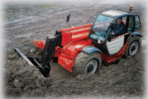
TERRASSEMENT : Levée/Descente + Cavage déversement
